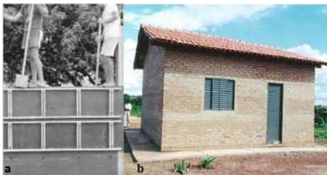
Figura 8 - (a) Execução de parede monolítica (CAMPOS, 2007). (b) Residência Popular feita com tijolos de solo-cimento (NEVES e SALMAR, 2009).
