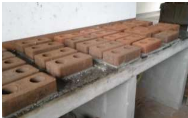
Figura 25 - Tijolos capeados com pasta de cimento.
